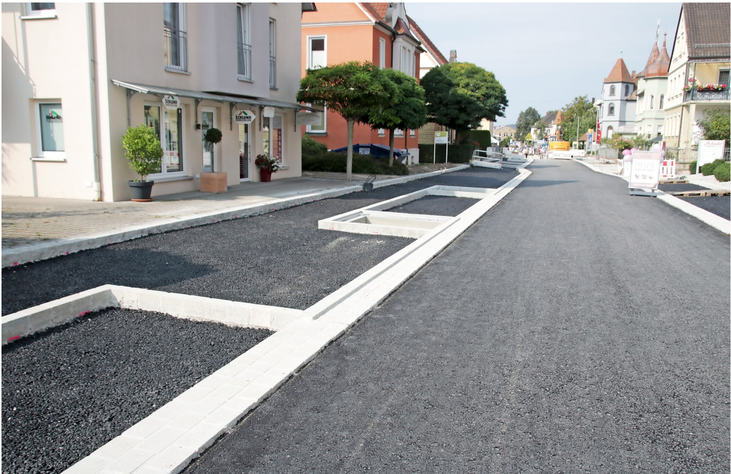
Sichtbarer Baufortschritt: In der Staffelsteiner Bahnhofstraße laufen derzeit die Asphaltierungsarbeiten. Deutlich zu sehen sind nun schon die Konturen der künftigen Parkbuchten.
